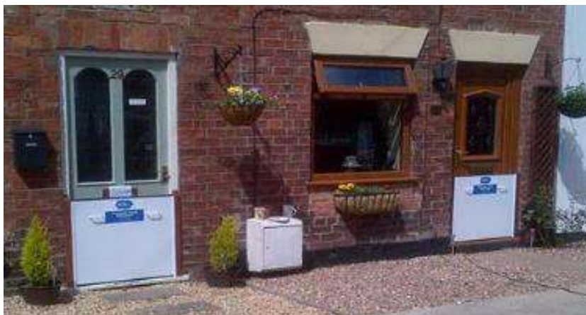
Figura 30- Paratoie manuali a protezione di porte di ingresso
