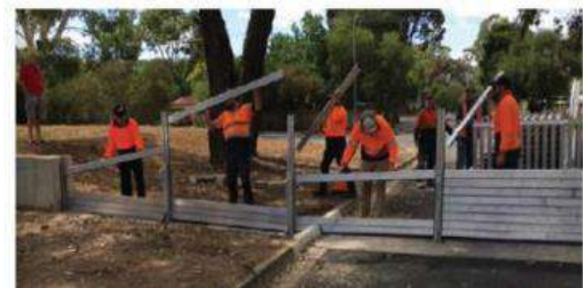
Figura 28 - Barriera temporanea modulare con pilastri e panconi manuali in alluminio
