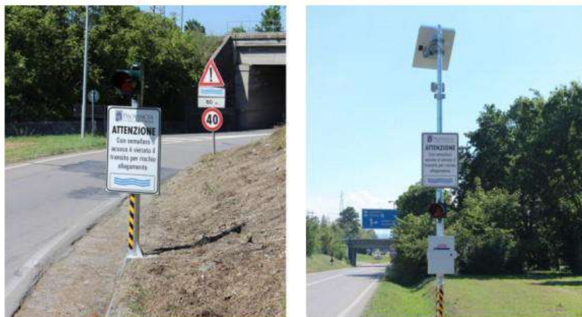
Figura 32 - Segnaletica e pannelli a messaggio variabile
