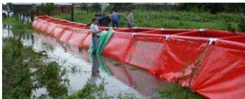
Figura 26 - Barriera temporanea antiesondazione riempita ad acqua
