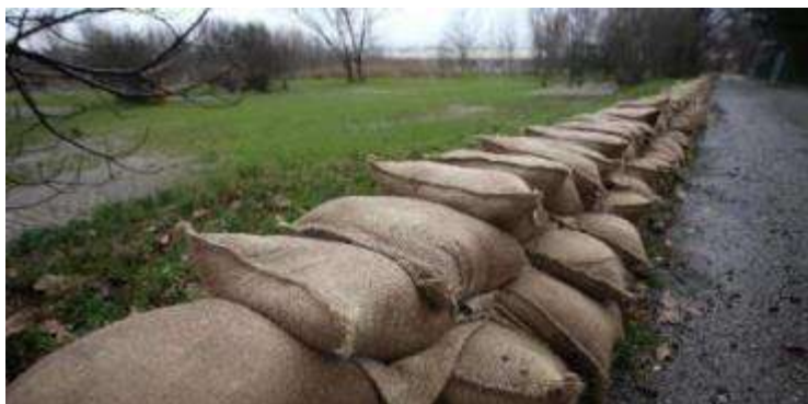
Figura 23 – Barriera temporanea antiesondazione in sacchi di sabbia
