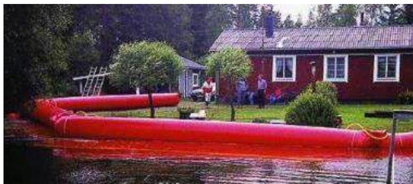
Figura 25 - Barriera temporanea antiesondazione riempita ad aria
